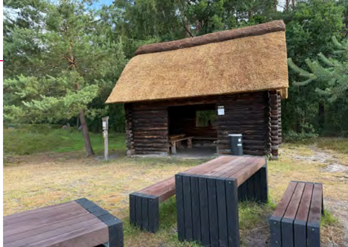
Neues Reetdach für die Schutzhütte in der Oldendorfer Totenstatt
