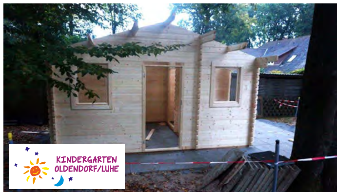
Holzstätte im Bau
